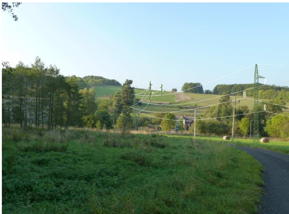
Obr. 4 – foto od (54) k (55) s přechodem silnice a železnice
